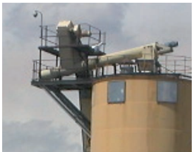
Figura 37 - Los sistemas de descarga de la explosión deben instalarse de manera que la descarga se produzca a lugar seguro sin afectar a otros equipos ni a los trabajadores.
